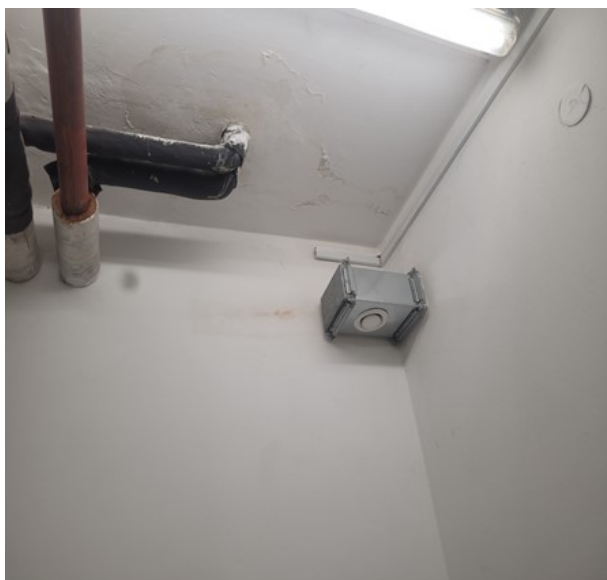
Slika 12, Slika 13: Zamakanje s stroga, dotrajan linolej
