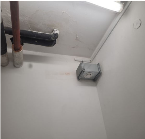
Slika 12, Slika 13: Zamakanje s stropa, dotrajan linolej
