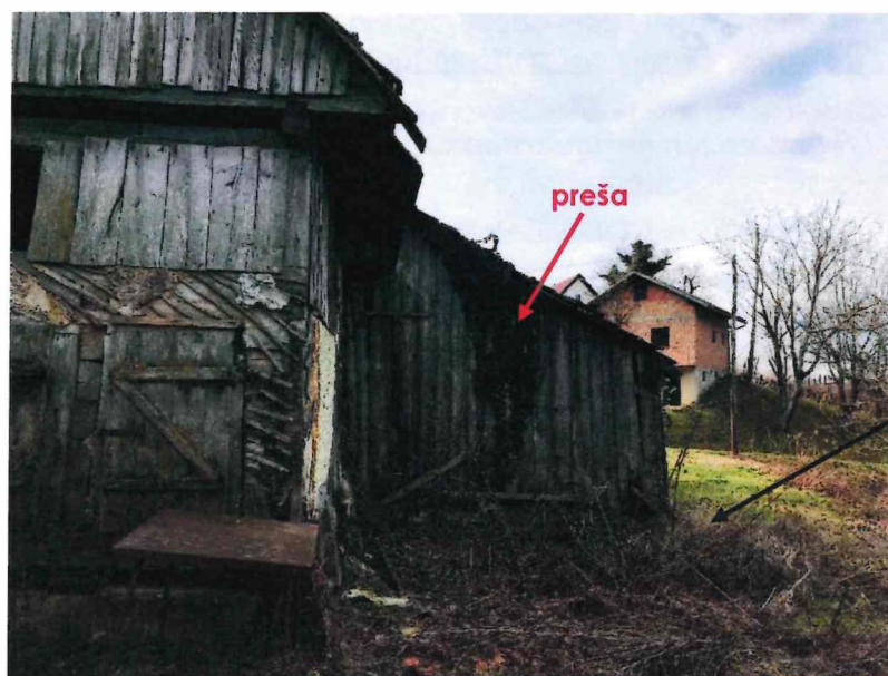
Slika 2: Pogled na del objekta – prešo s severovzhodne strani.
