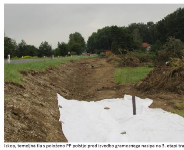
Izkop, temeljna tla s položeno PP polotjeto pred izvedbo gramoznega nasipa na 3. etapi trase
