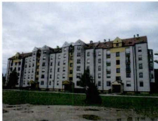
Stavba Engelsova ulica 46 - 52
