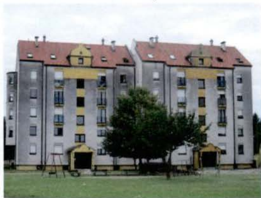
Stavba Engelsova ulica 42 - 44
