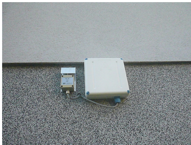
Antene na objektu za prenos komunikacij med toplarno in objektom
