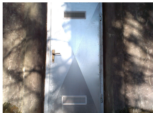
Vhodna vrata v objektu vodohran R6
