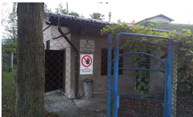
Vodohran Gvido pred obnovitvenimi deli
