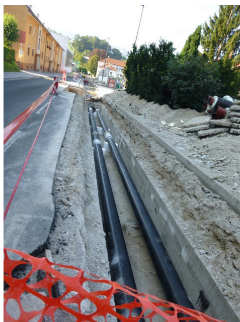
Obnova 3. faze, pogled proti občinski stavbi
