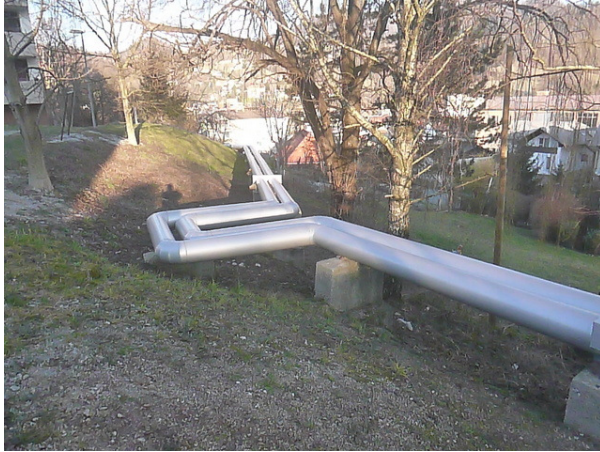
Obnova vročevoda na odseku Keršičeva cesta – Dom upokojencev
