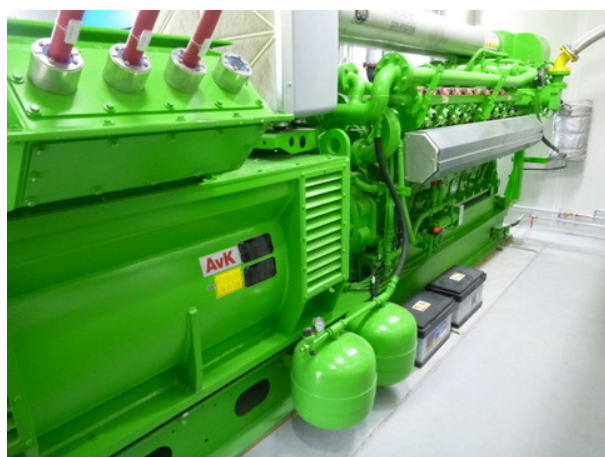
Plinska motor kogeneracijska enota SPTE 3
