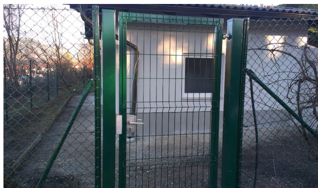
Nova vrata in ograja v sklopu ograje pri vodohranu Gvido
