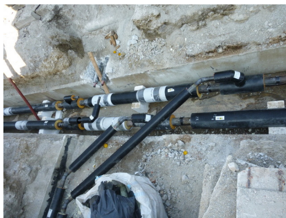
Vozlišče z odcepom za OŠ Trbovlje
