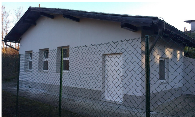
Vodohran Gvido po obnovi
