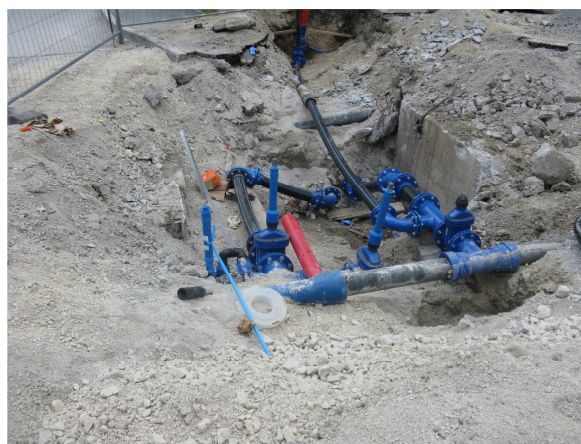
Obnova križišče Kamnikar-Zdravstveni dom Cevovodno vozlišče v križišču pri Kešetovo 4
