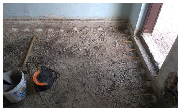
Obnova predprostora v objektu
