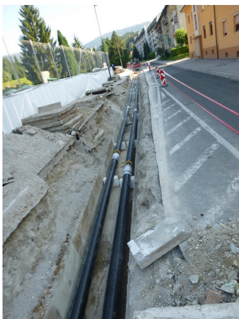
Obnova 3. faze, pogled proti Mercatorju
