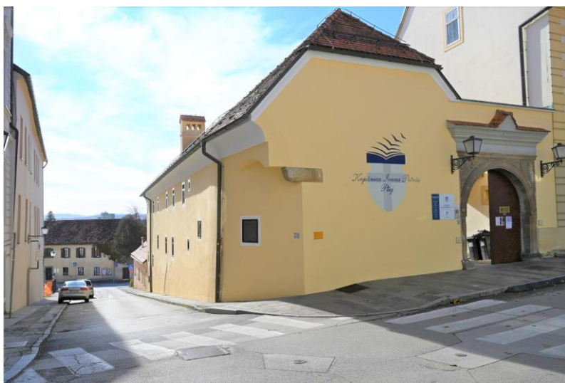
Fasada po obnovi (foto: Alfonz Zavrnik)
