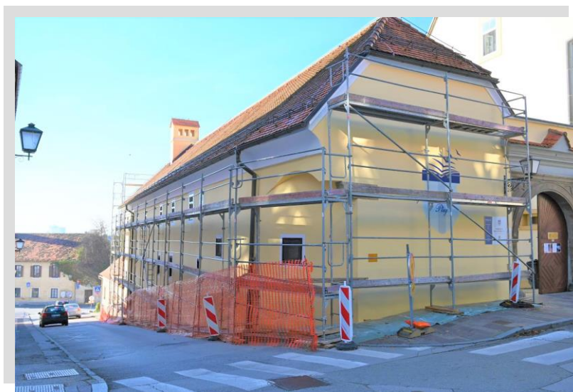
Fasada med obnovo (foto: Alfonz Zavrnik)
