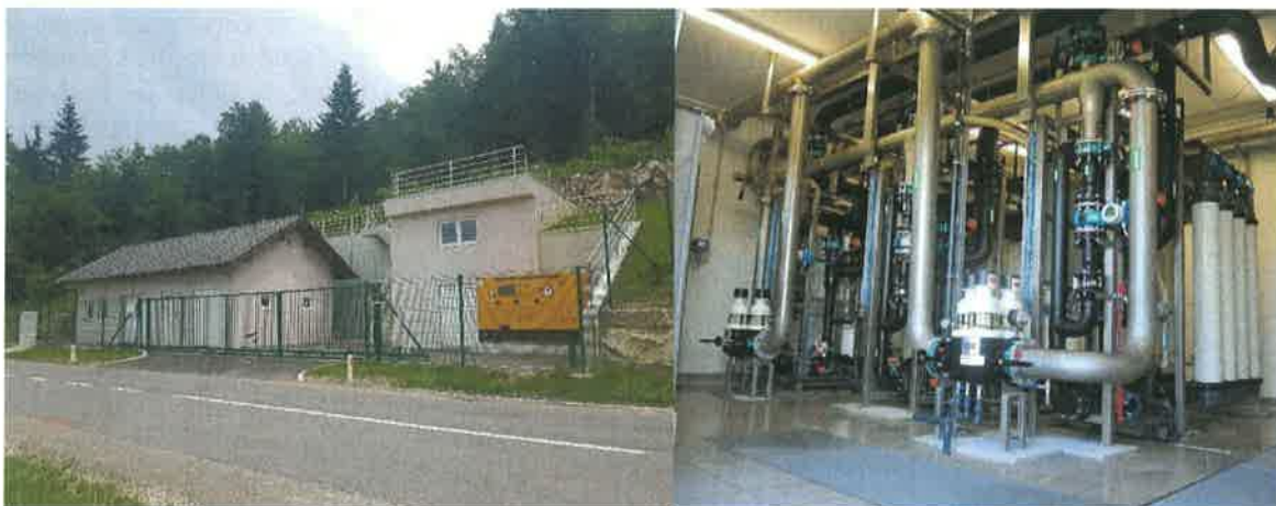
Vodarna Virje z ultra filtracijskimi enotami
