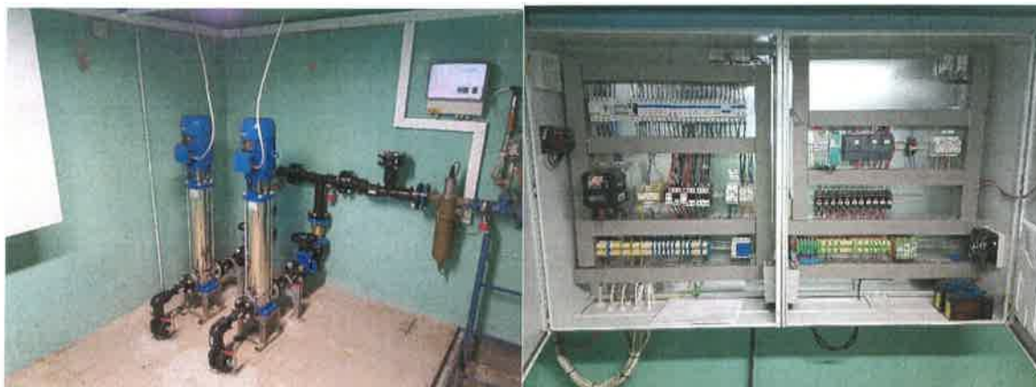
Prenova črpališča Dolenja Brezovica in zamenjava dotrajane elektro omare
