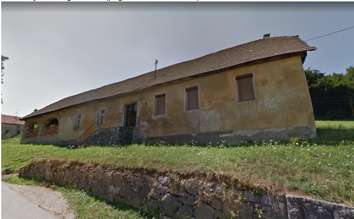
Slika: Objekt Pod gradom 5 (pogled iz severozahoda)
