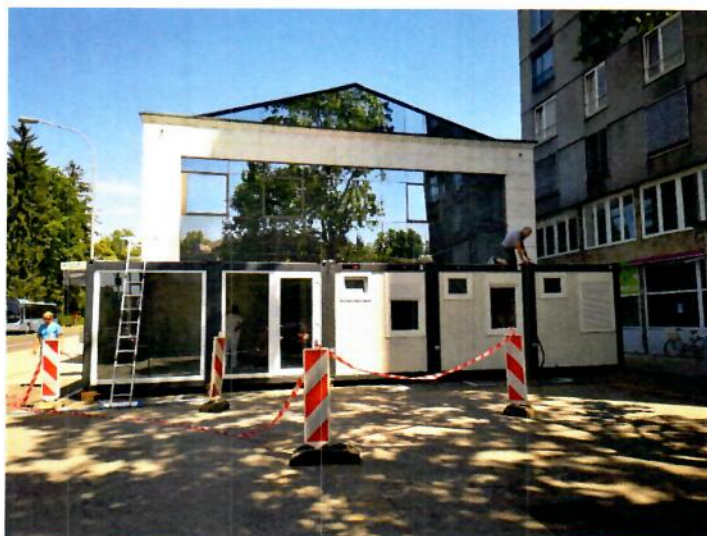
Slika 3: Nameščanje kontejnerjev za začasno lekarno
