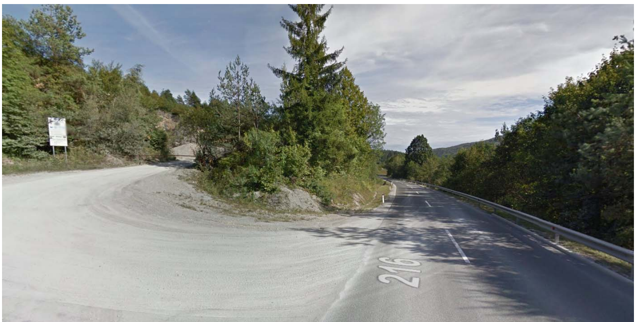
Slika 5: Pogled na obravnavani priključek kamnoloma »Vrčice« – gledano v smeri proti naselju Semič
