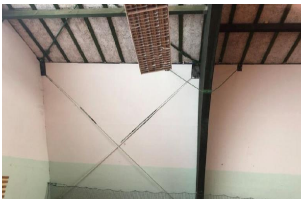
Slika 7: Notranjost objekta – detajl konstrukcije
