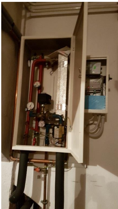
Slika 6: Primer toplotne postaje v sistemu DOLB Preddvor
