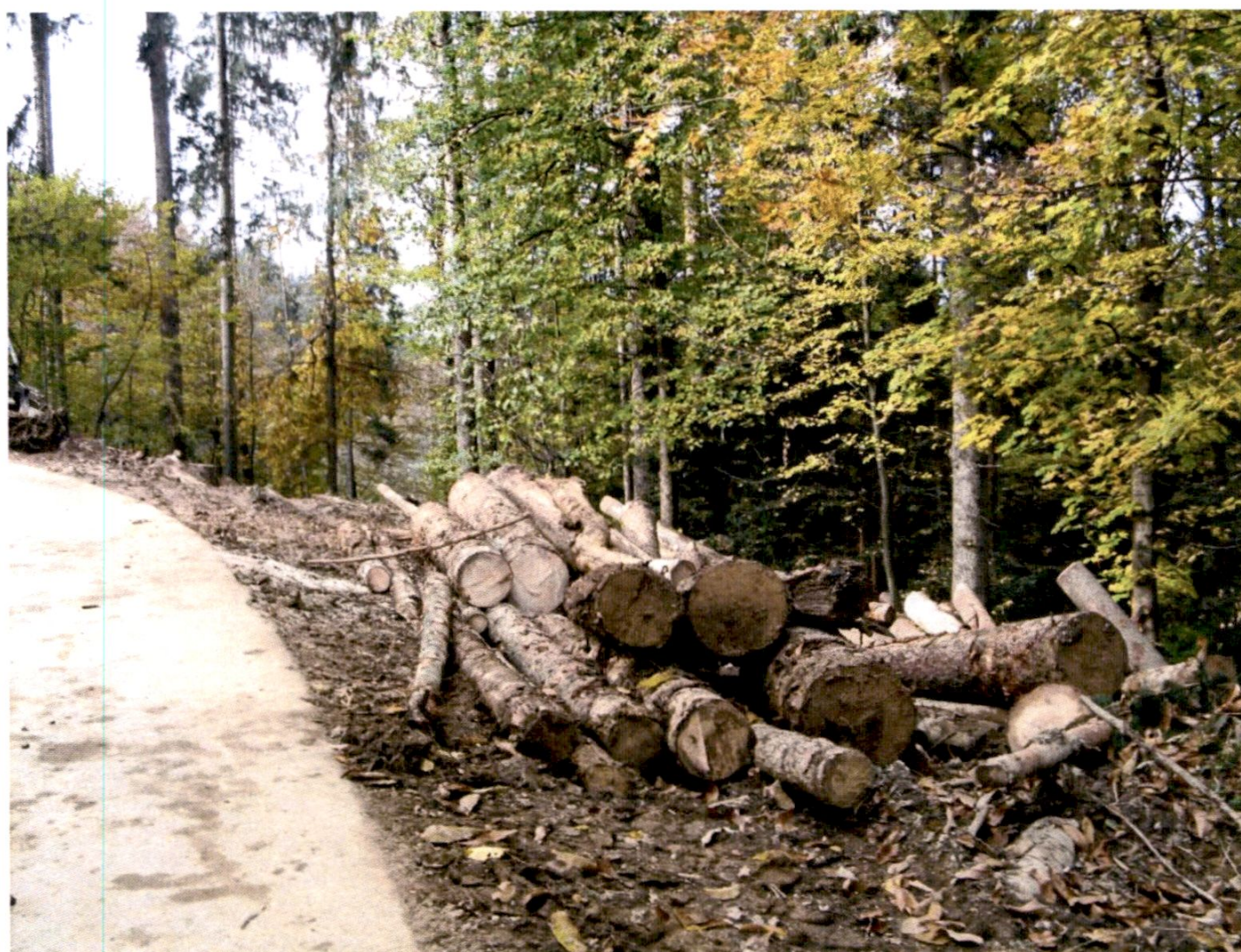
Slika 5: Onesnaženje oziroma poškodba občinske ceste.
