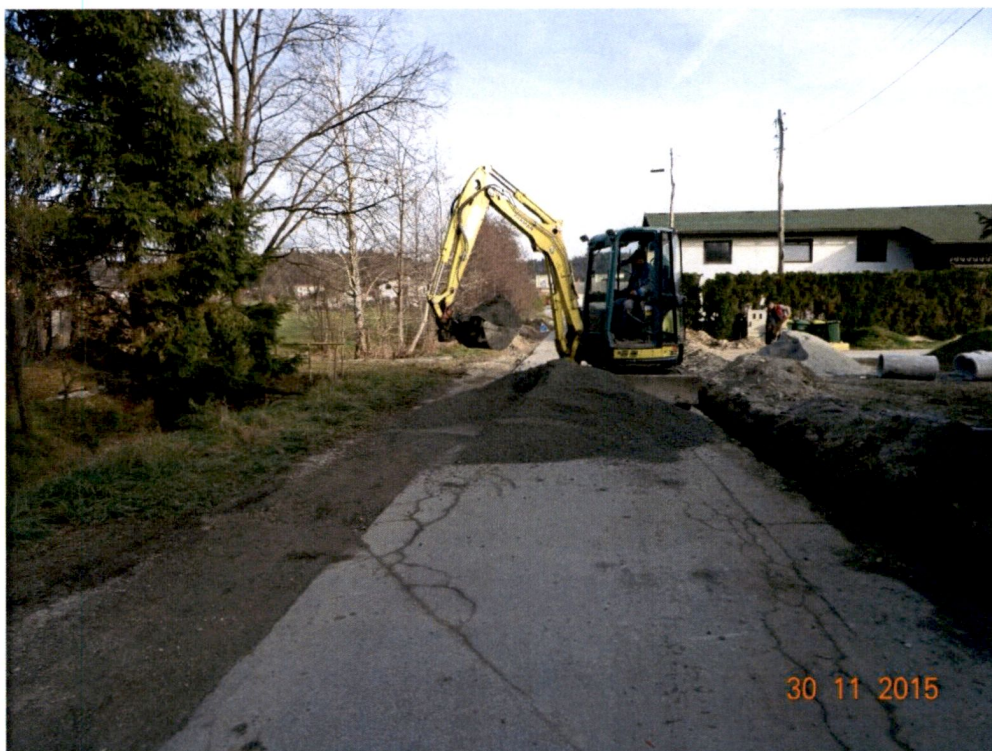
Slika 4: Izvajanje del na cestišču občinske ceste.
