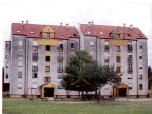
Stavba Engelsova ulica 42 - 44
