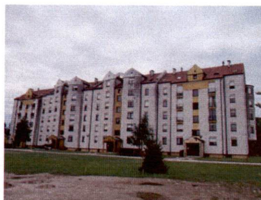
Stavba Engelsova ulica 46 - 52
