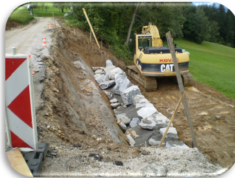
Slika 29: Sanacija plazov Bezovje
