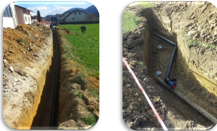
Slika 53 in 54: Zamenjava vodovodnih cevi v Ulici bratov Mernik
