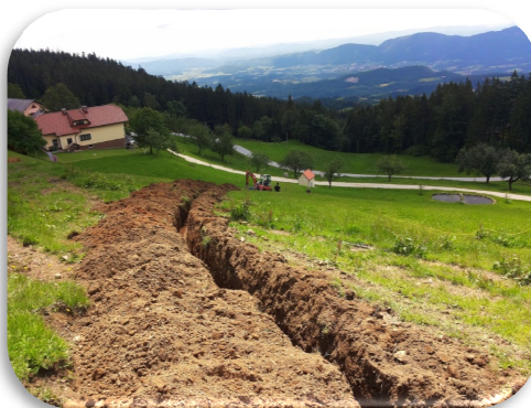
Slika 55: Izgradnja vodovodnega sistema na Planini
