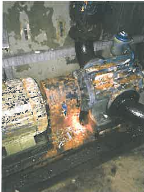
Slika 5: Kompressor za rahljanje filtrske mase
