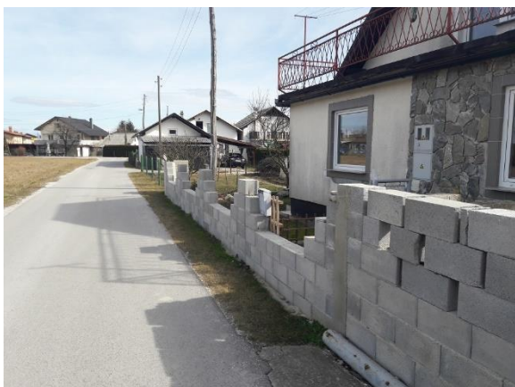
Gradnja ograje v varovalnem pasu občinske ceste
