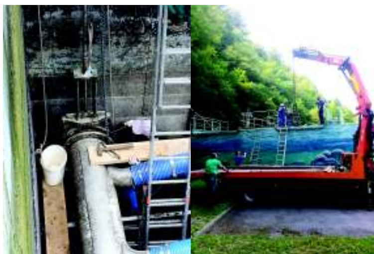
Odstranitev in transport zaporne lopute
