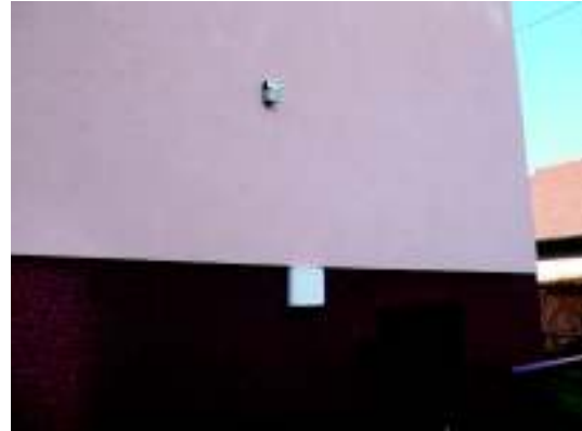
Objekt Keršičeva cesta 22a
