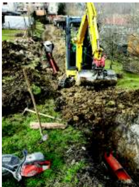
Obnova sekundarnega kanala Kolonija 1. maja
