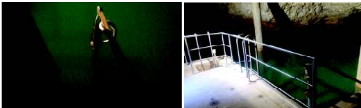
Merilnik motnosti in varovalna ograja v vodohranu, zajetju Mitovšek
