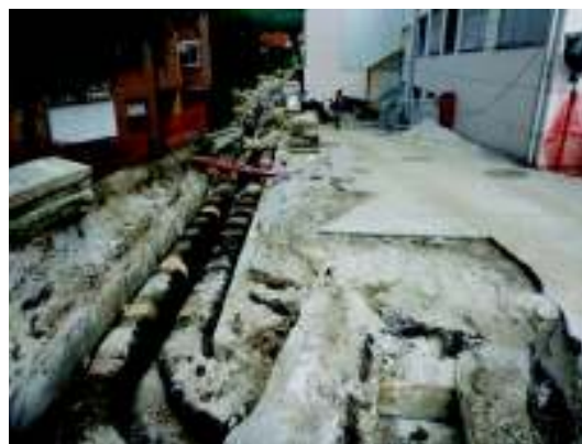
Vročevod pred obnovo poleg STPŠ
