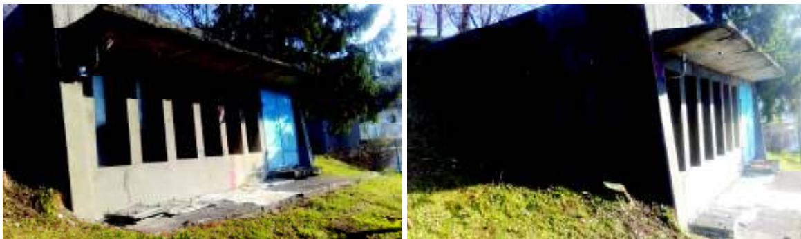
Vodohran Vreskovo pred obnovitvenimi deli
