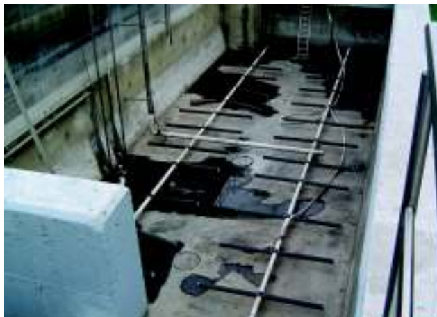
Puhala na dnu izpraznjenega in očiščenega SB
