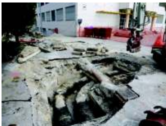
Vročevod pred obnovo Šuštarjeva 1
