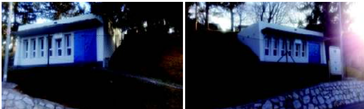
Vodohran Vreskovo po obnovi
