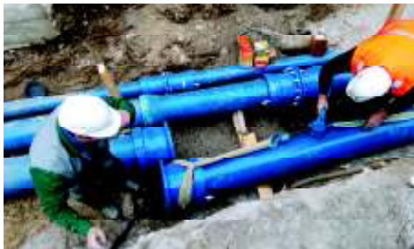
Obnova po skalnem podoru
