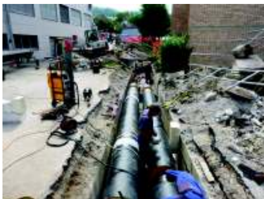
Obnova vročevoda pri Šporni dvorani Polaj
