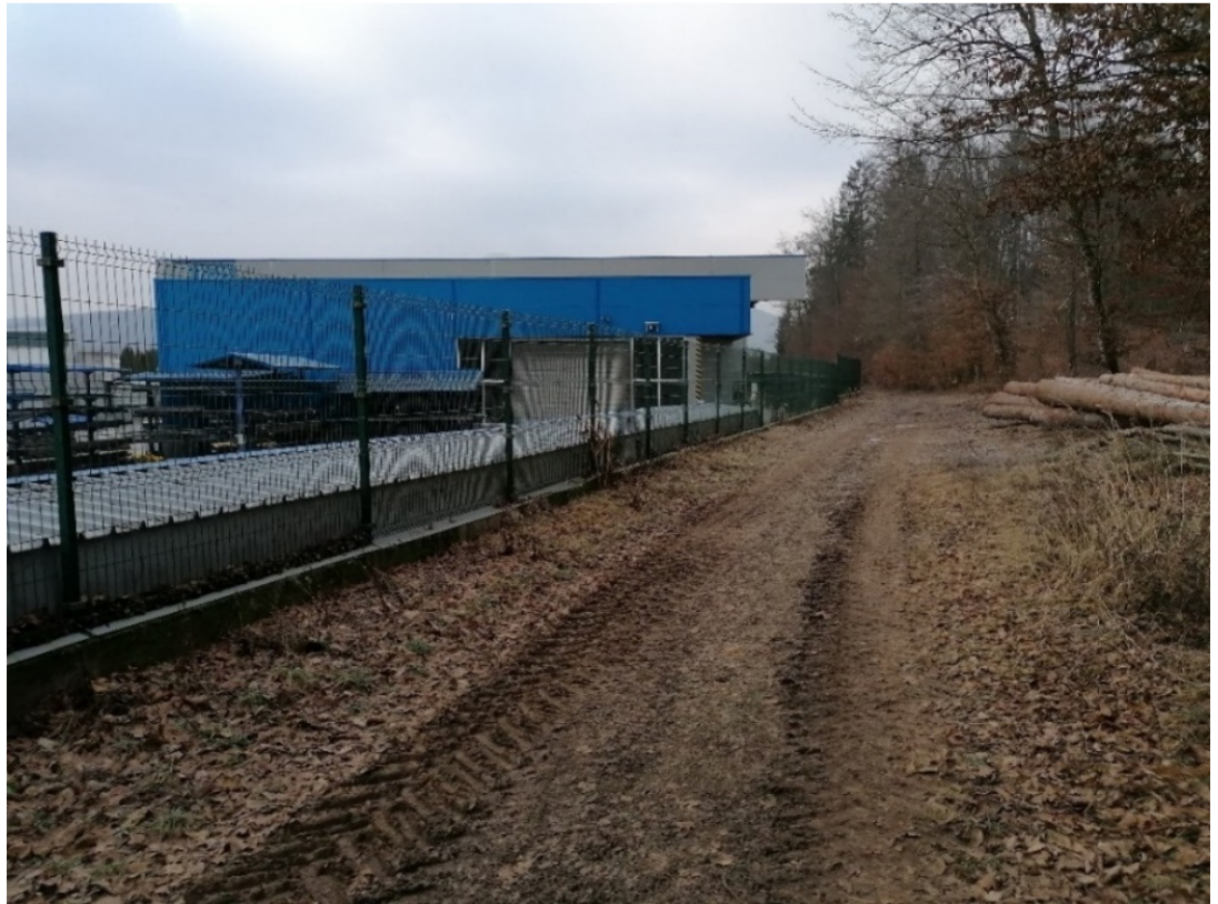
Slika 1: Obstoječe stanje zalednega zidu - pogled proti zahodu (foto: EHO Projekt)
