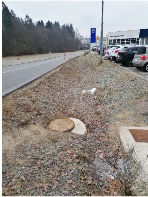
Slika 3: Začetek odvodnega jarka, kamor bo predvidoma speljana cev za odvajanje vode izza zaledenega zidu, pogled dolvodno (foto: EHO Projekt)
