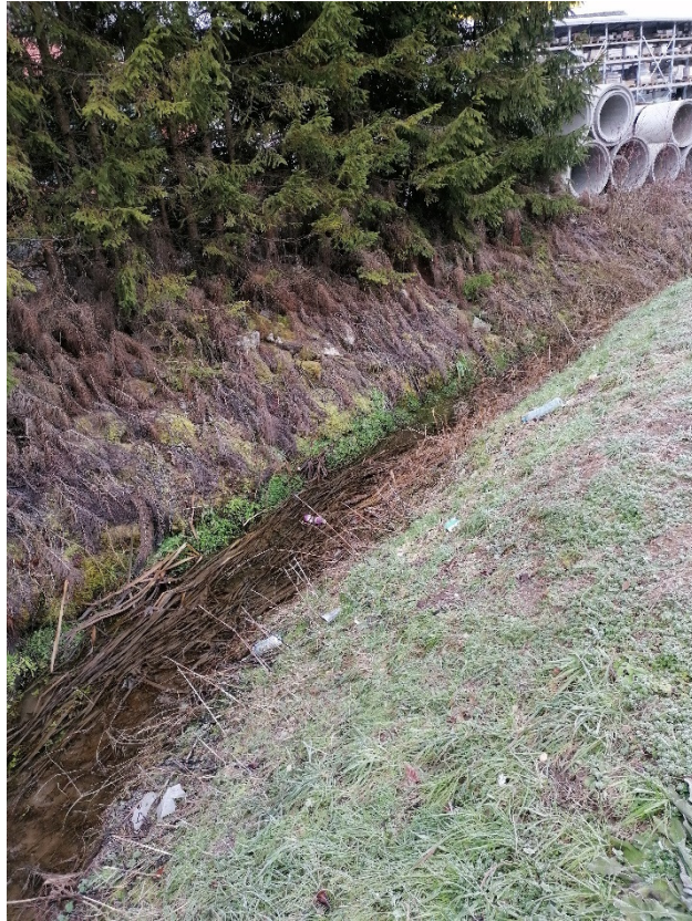
Slika 9: Obstojęča struga na odseku ODS 1, gorvodni pogled (foto: EHO Projekt)
