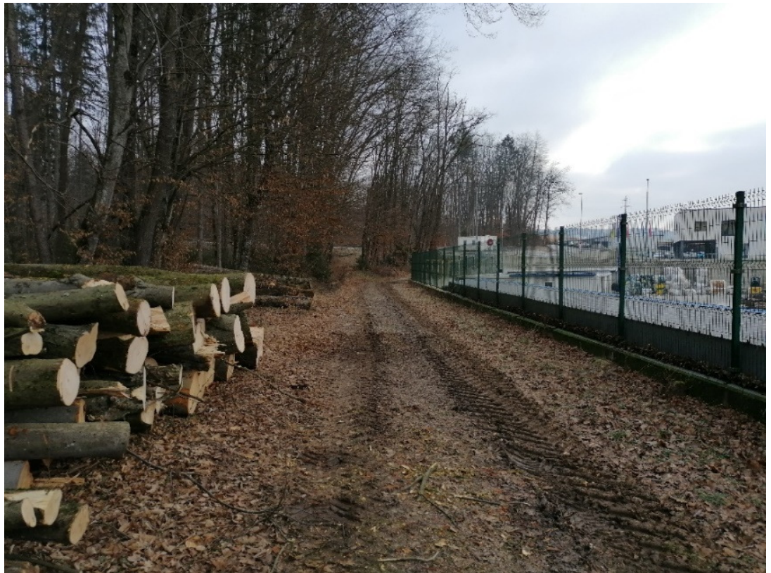
Slika 2: Obstoječe stanje zalednega zidu - pogled proti vzhodu (foto: EHO Projekt)
