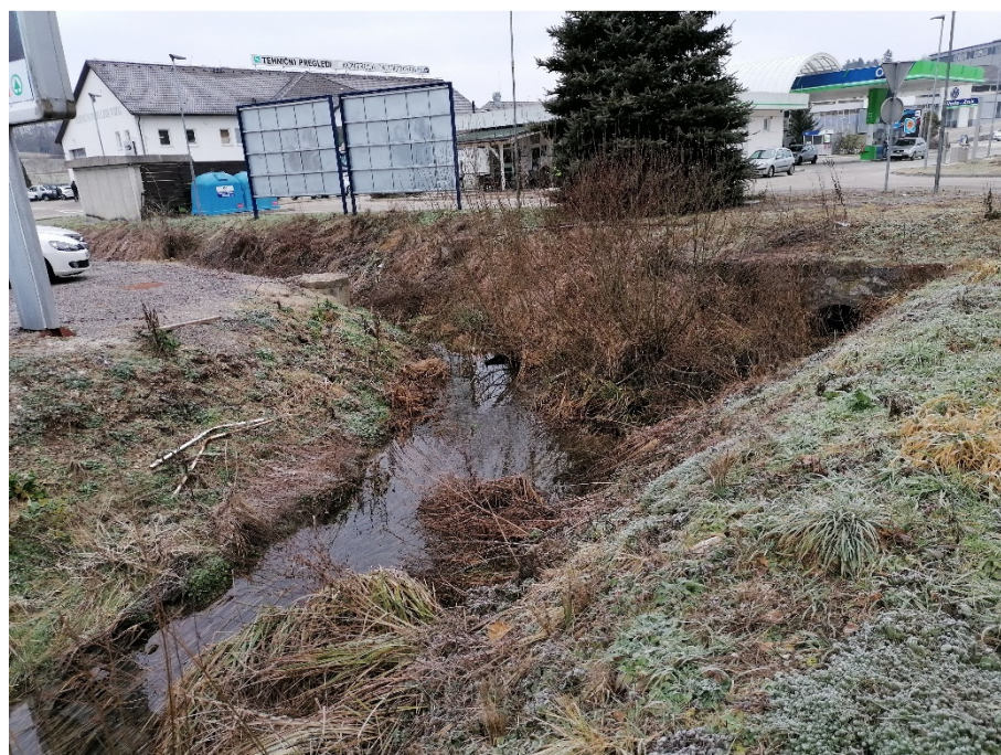
Slika 13: Obstoječe stanje sotočja ODS 1 in ODS 2 (foto: EHO Projekt)
