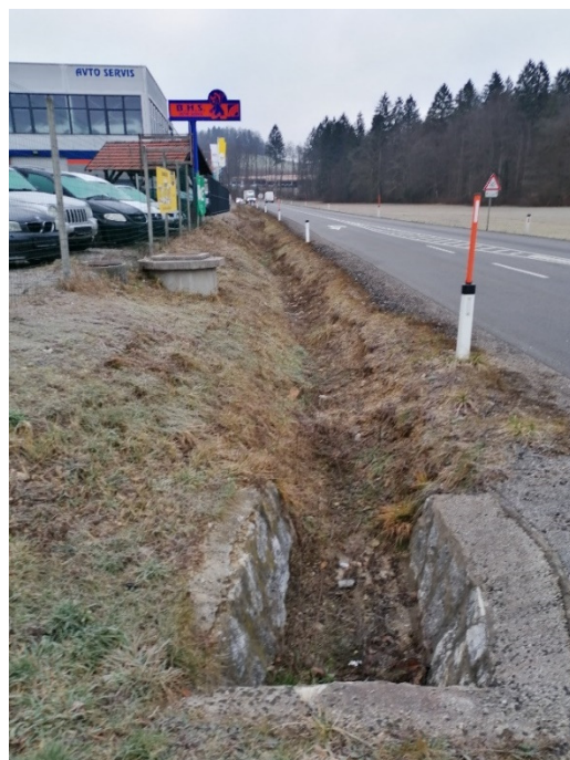
Slika 3: Začetek odvodnega jarka, kamor bo predvidoma speljana cev za odvajanje vode izza zaledenega zidu, pogled dolvodno (foto: EHO Projekt)
