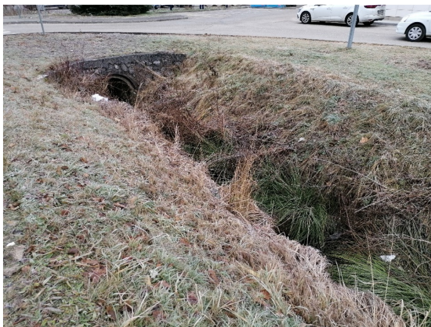
Slika 12: Obstoječa struga na odseku ODS 2, zaraščena struga pred zacevitvijo ob bencinskem servisu (foto: EHO Projekt)
