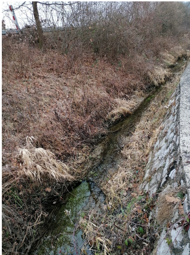
Slika 16: Dolvodni del obstoječe struge na odseku ODS 3, desna brežina s kamnito betonskim zidom, naravna leva brežina, nad njo železnica (foto: EHO Projekt)
