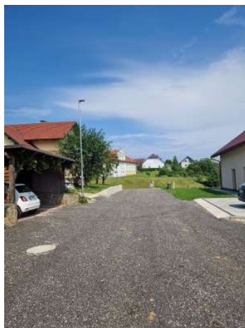
Slika 15: Zaključena I. faza ureditve komunalne opreme ulice Cerkevjak-Govedič
