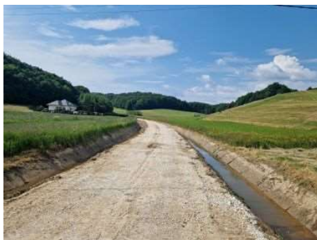
Slika 14: Odsek ceste v naselju Brengova pred asfaltiranjem (003)
