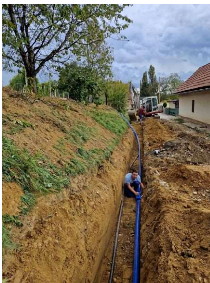
Slika 20: Sočasna gradnja optičnega omrežja ter vodovoda v naselju Grabonoški Vrh
