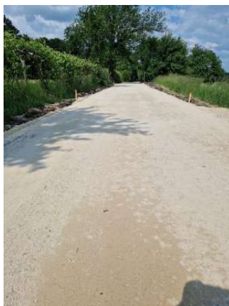
Slika 13: Odsek ceste v naselju Komarnica v izvajanju sanacije (003)
