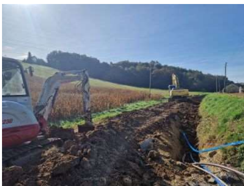
Slika 19: Sočasna gradnja optičnega omrežja ter vodovoda v naselju Župetinci
