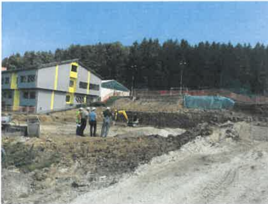
Slika 6: Izkop temeljev Centra za Zdravje in šport
