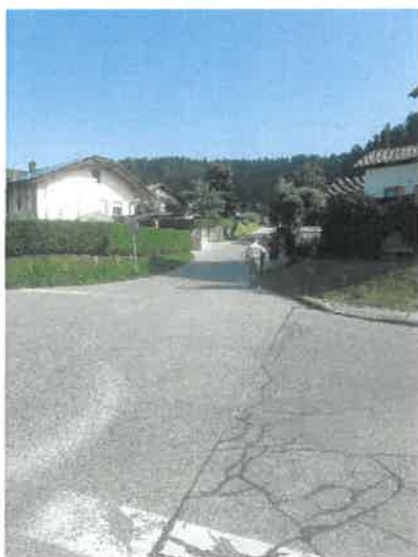
Slika 4: Stanje pred izvedbo rekonstrukcije
