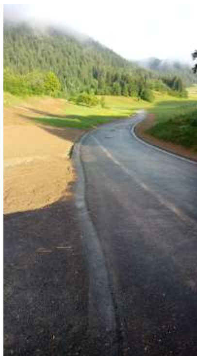
Slika: Obnova ceste ob izgradnji ponikovalnice v Retjah
