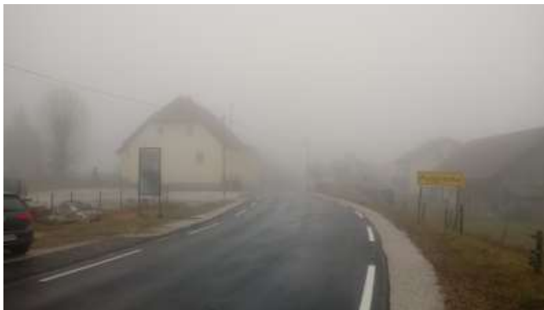
Slika: Rekonstrukcija ceste skozi vas Podpreska
