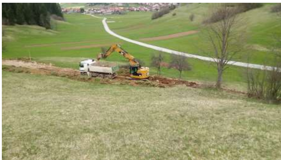
Slika: Gradnja Ponikovalnice v Retjah
