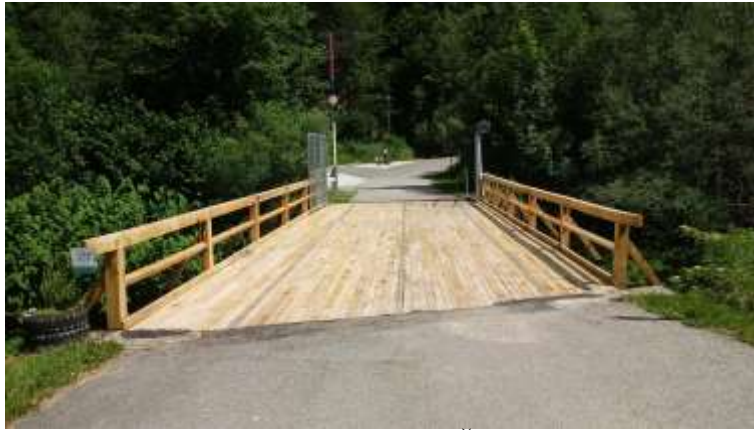
Slika: Obnovljen most v Črnem Potoku
