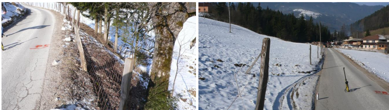
Slika 4: Brežina pod cesto, nadaljevanje.
