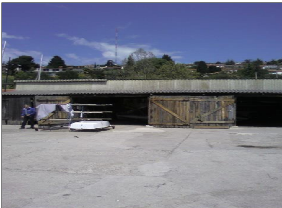
Slika 1: Nekdanji leseni hangar – pogled od daleč
