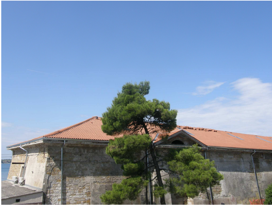
Pogled na novo strešno kritino tik pred zaključkom del.
