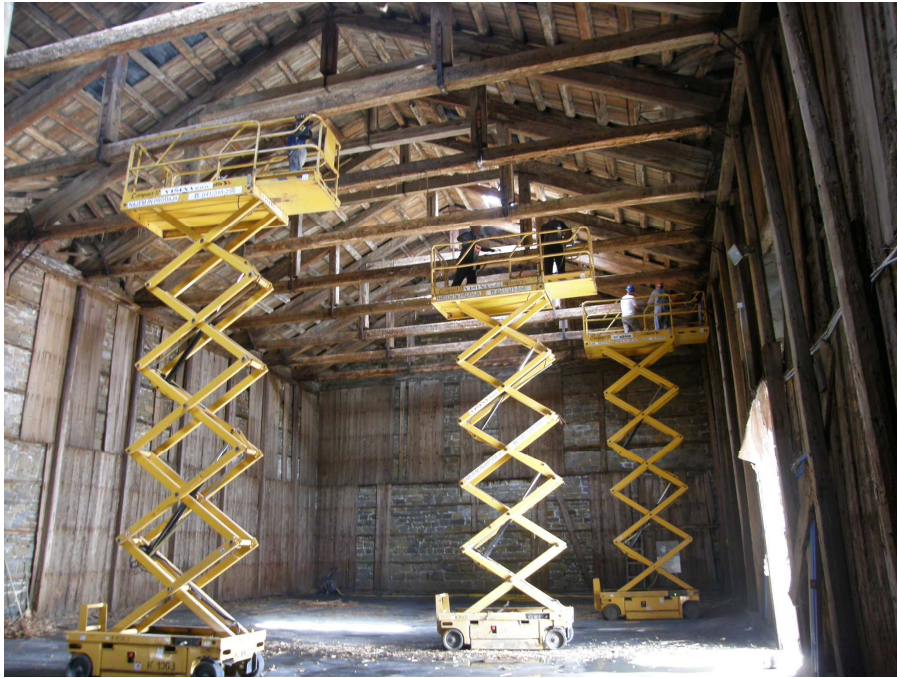
Dela so se izvajala na višini s pomočjo dviznih košar.
