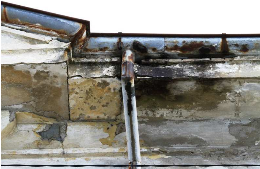
Žlebovi in odtoki iz pocinkane pločevine so bili zarjaveli, vidna so številna zamakanja.
