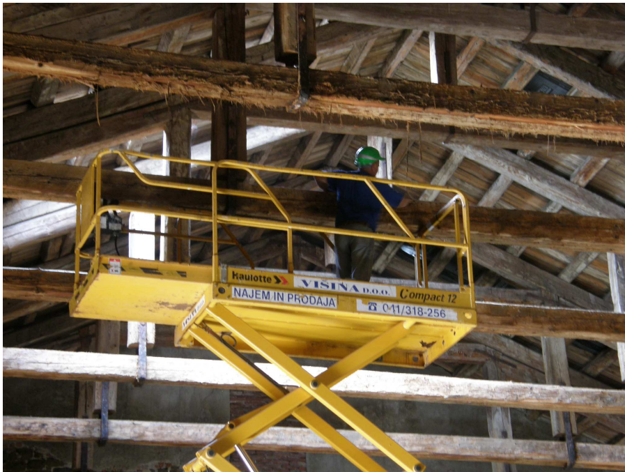
Vsak element je bil skrbno pregledan, ščetkan, spran, zamenjani so bili kovinski spojni elementi.
