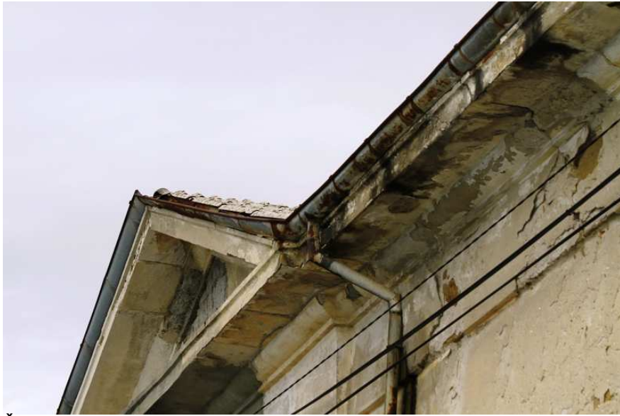
Žlebovi in odtoki iz pocinkane pločevine so bili zarjaveli, vidna so številna zamakanja.
