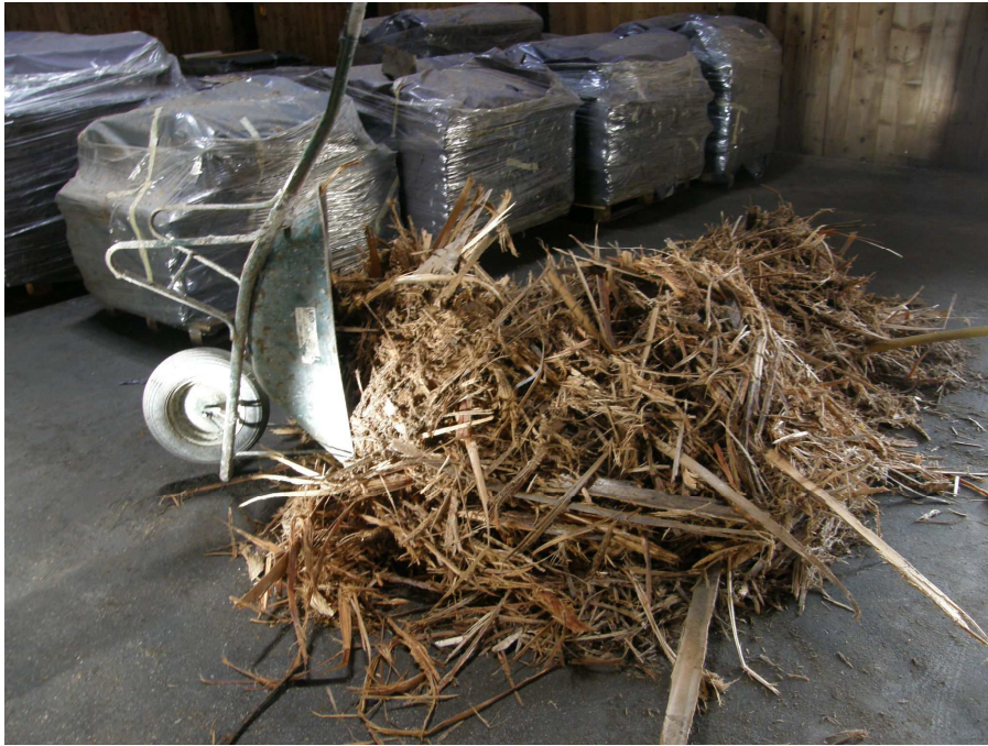
Salonitna kritina je bila skrbno odstranjena in zavita v PVC folije skladno s predpisi. Odstranjen je bil ves preperel in s soljo napojen les.
