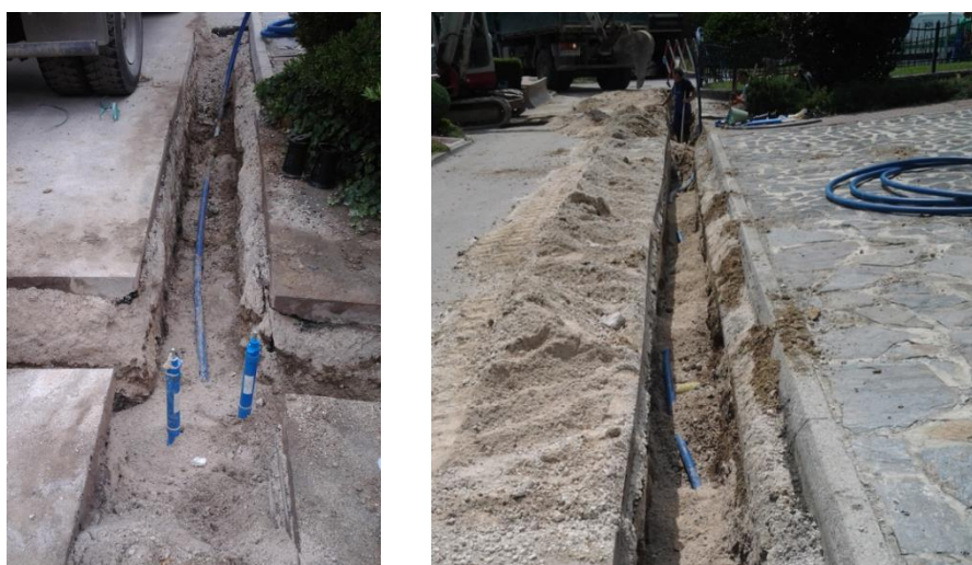
Slika 4: Obnova vodovoda – Ulica Borisa Vinterja
