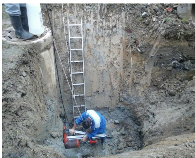
Slika 8: Izvedba prevezave sekundarnega kanala na jašek javne kanalizacije na Vešeniku
