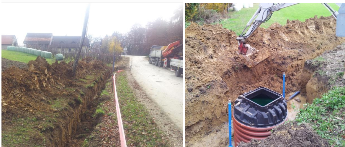
Slika 2: Obnova cevodov Ličenca - Grušovje
