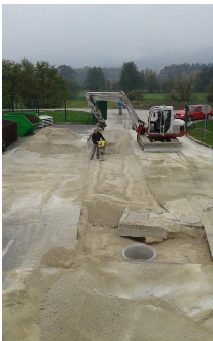
Slika 7: Izvedba prevezave izcednih voda na CERO SK (vir: arhiv JKP)
