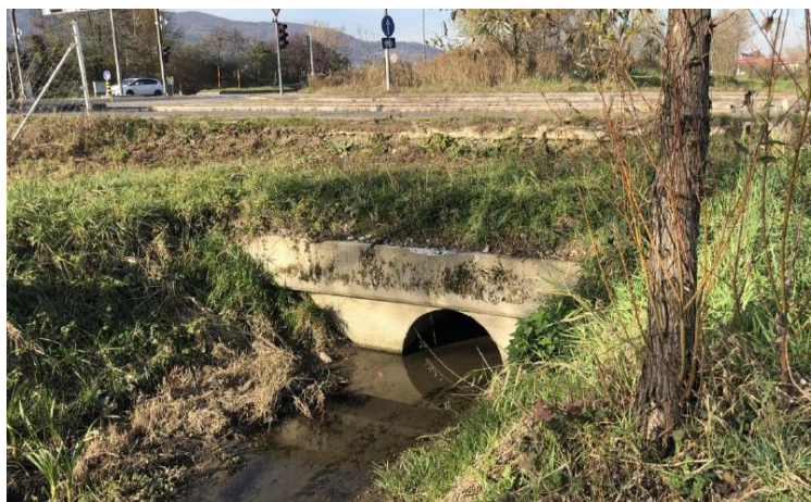
Slika 6-8: Obstojec prepust pod že izvedenim krakom križišča - zahodno od meje obdelave
