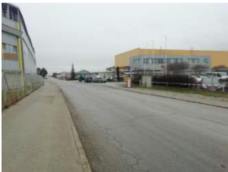
Slika 6-14: Obstoječa JP – bodoče površine za hodnik za pešce v km 0+570
