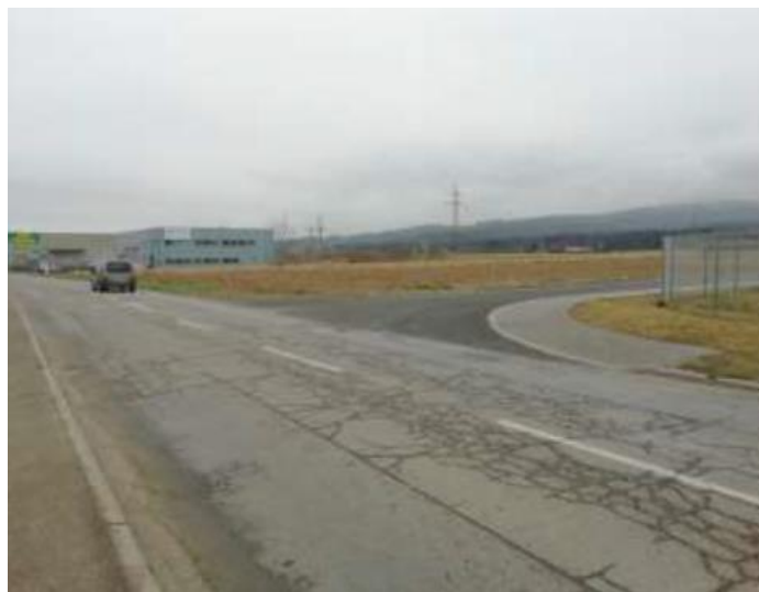
Slika 6-12: Obstoječa JP – priključek v km 0+280 desno
