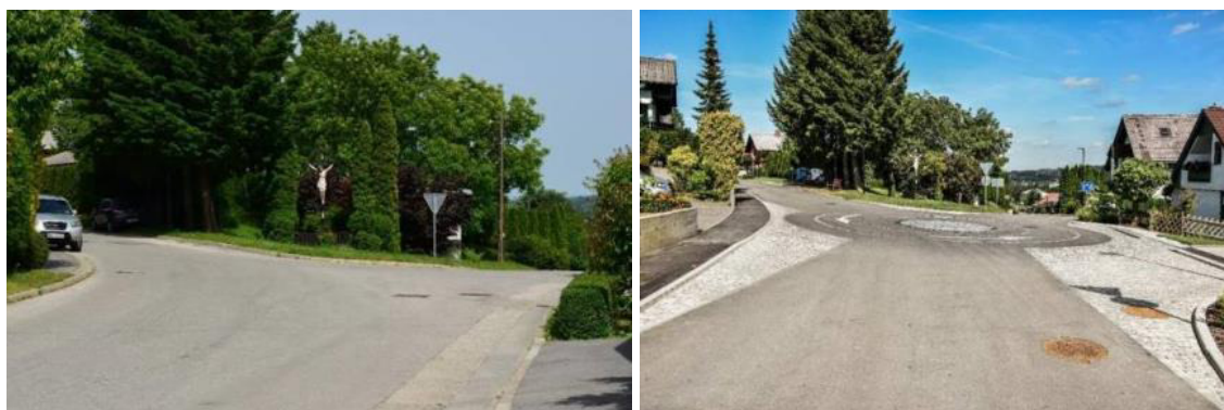
Slika 65: Primer urbane prenove ulice v soseski v Ljutomer (prej in potem)
