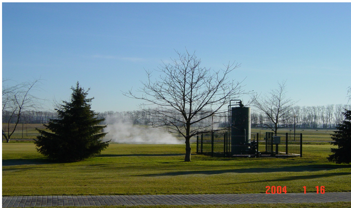
Slika 50: Ustje vrtine za črpanje geotermalne vode v Moravskih Toplicah
