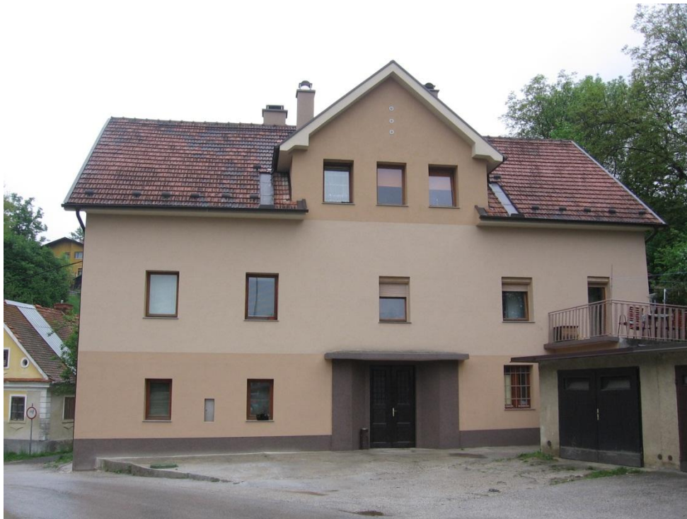
OBNOVLJENA FASADA NA OBJEKTU TRG FRANCA FAKINA 36
