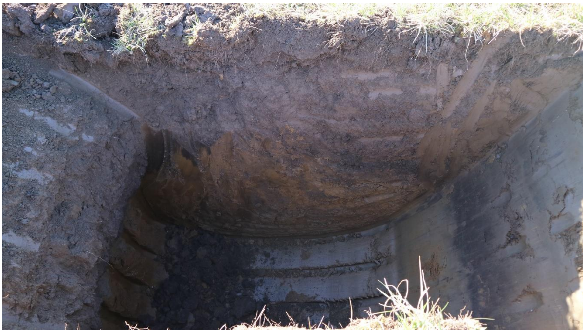
Slika 2. Pogled na izkopan tesni jarek.
