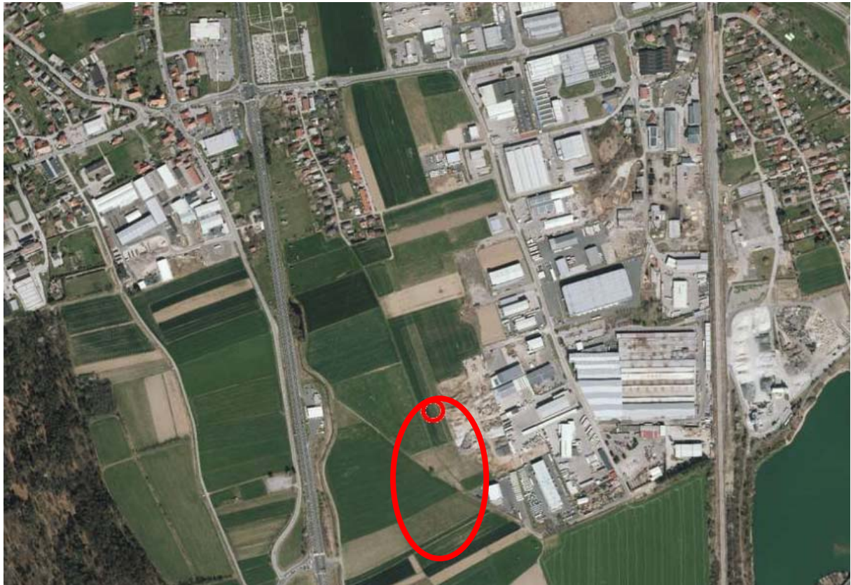
Slika 7: Območje plana je na kmetijskih zemljiščih zahodno od obstoječe industrijske cone.
