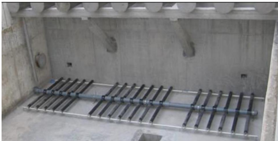
Slika 19: Aeracijski sistem
