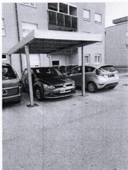
Gradnja enostavnih objektov ob Mariborski cesti
