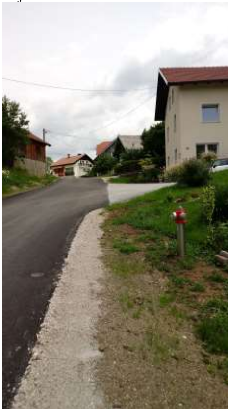
Slika: Obnova ceste Bela voda
