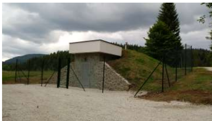
Slika: Obnova vodovoda Travnik (novi vodohran)
