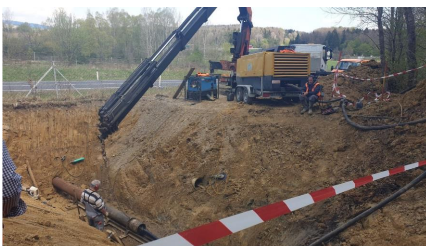
Podboj avtocestnega priključka pri izgradnji vodovoda Sp. Nova vas
