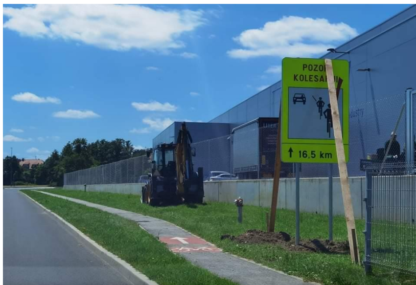
Postavitev vertikalne signalizacije na lokalni cesti Slov. Bistrica – Tinje
