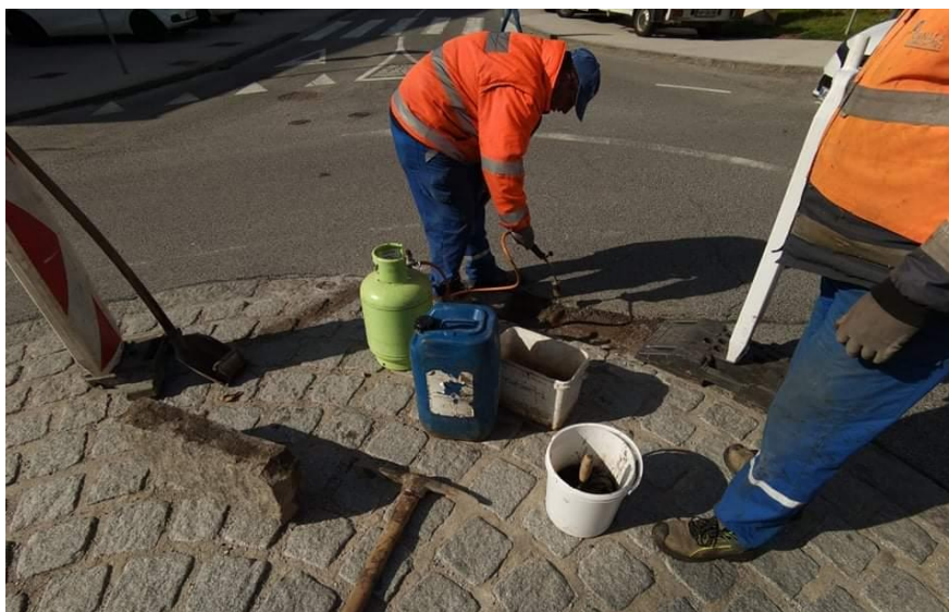
Sanacija granitnih kock v krožišču na Partizanski ulici
