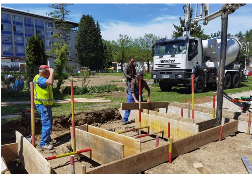
Izdelava temeljev za vgradnjo igral na Tomšičevi ulici v Slovenski Bistrici
