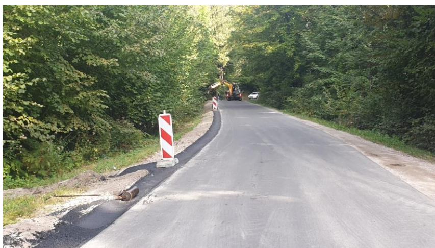
Izdelava asfaltnih muld na lokalnih cestah
