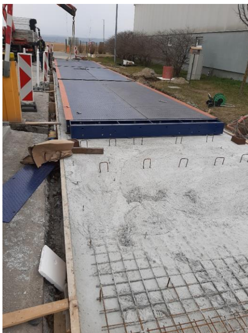
Temelji nove tehtnice
