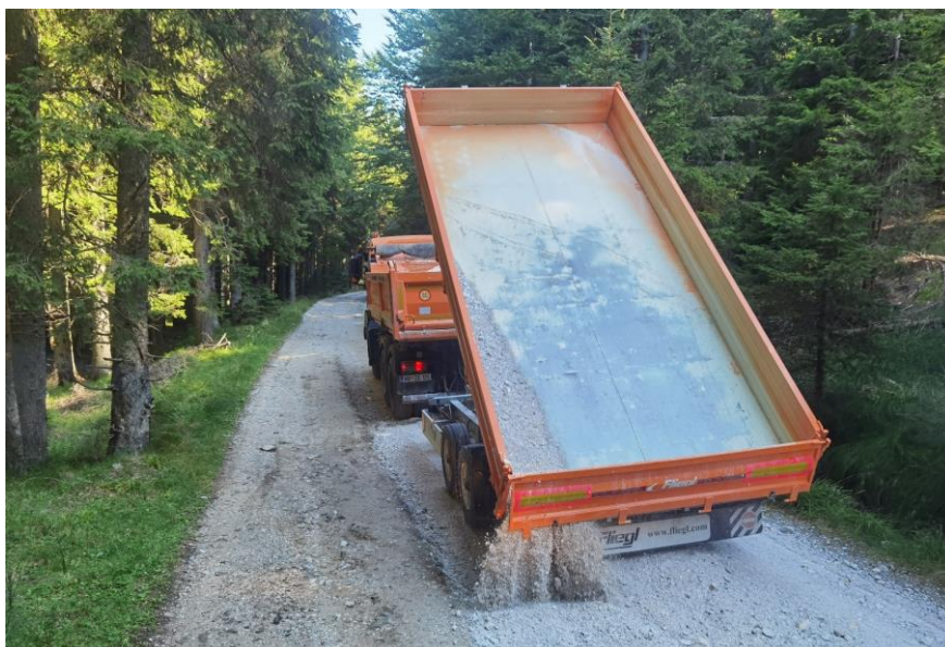
Gramoziranje makadamskega vozišča na lokalni cesti na Pohorju
