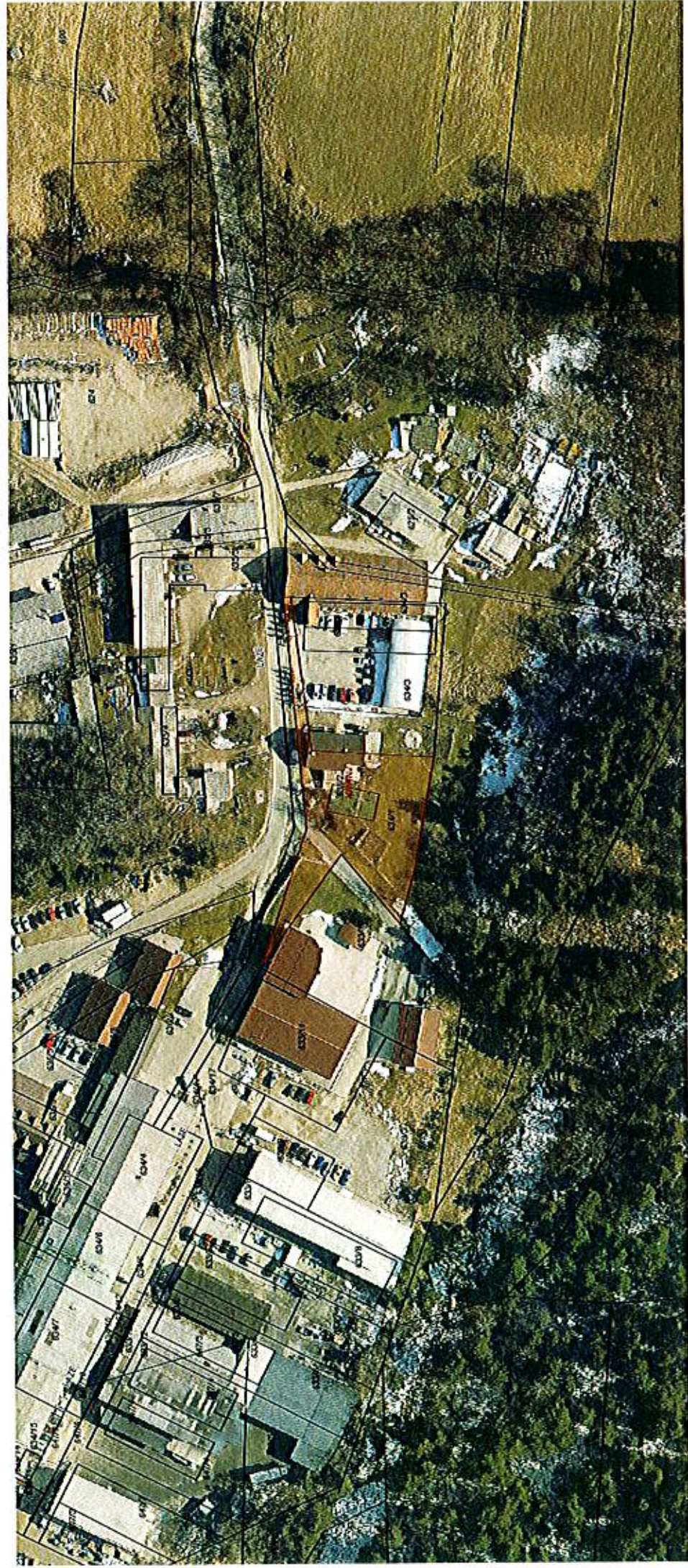
Zemljišče za transformatorsko postajo TP Laze – del parc. št. 634/1, k.o. Stražišče
