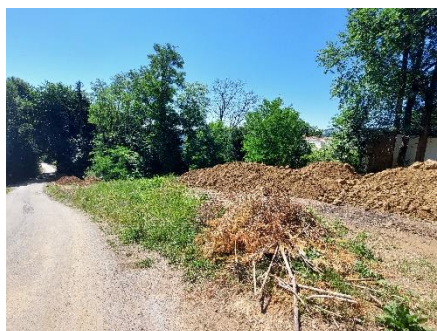
Gradnja nasipa v Pivoli
