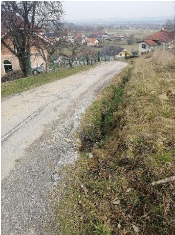
Zaraščen odvodni jarek v Zgornjih Hočah
