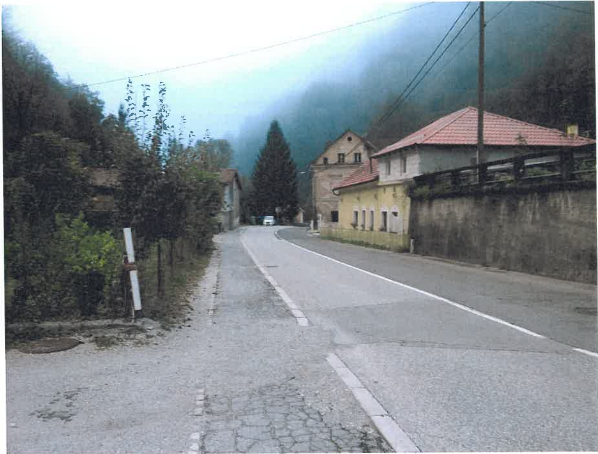
Slika 5: Območje operacije - Desni rob regionalne ceste, kjer sta objekt in oporni zid locirana skoraj do ceste - predvidena izgradnja pločnika
