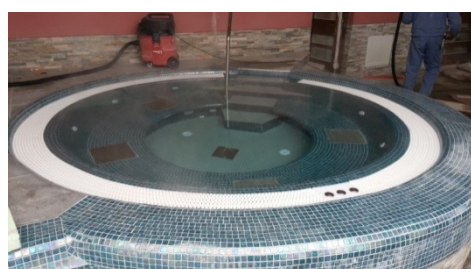
fina montaža zunanji bazen
