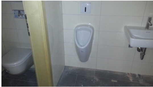
montaža sanitarne opreme
