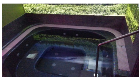
notranji bazen fina montaža
