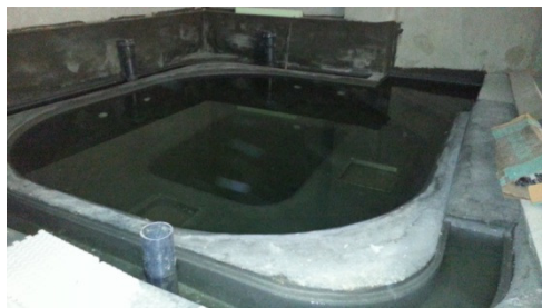
tesnjenje bazenov in testnostni preizkus
