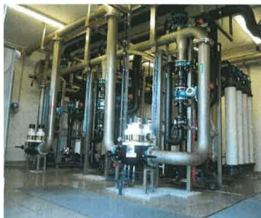
Vodarna Virje z ultra filtracijskimi enotami
