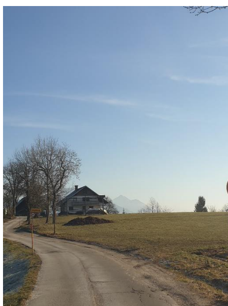
Slika 34: Ozka cesta v Podhому z neutrjenim robom vozišča, ki je dodatno v slabšem stanju zaradi poletnih prometnih obremenitev
