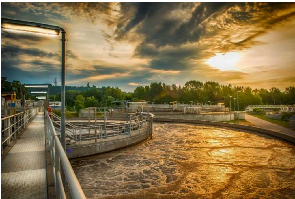
Slika 11: CČN Maribor – biološko čiščenje (vir: http://aquasystems.si/sl-si/CČN-Maribor/Proces )
