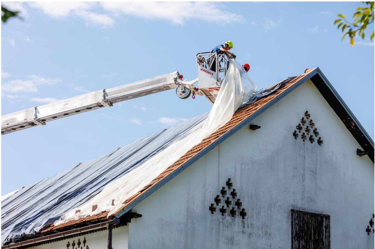
Izvajanje nujnih zaščitnih ukrepov na poškodovanih objektih
