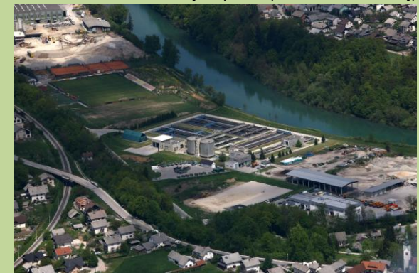
Centralna čistilna naprava Kranj (Foto: Gorazd Kavčič)
